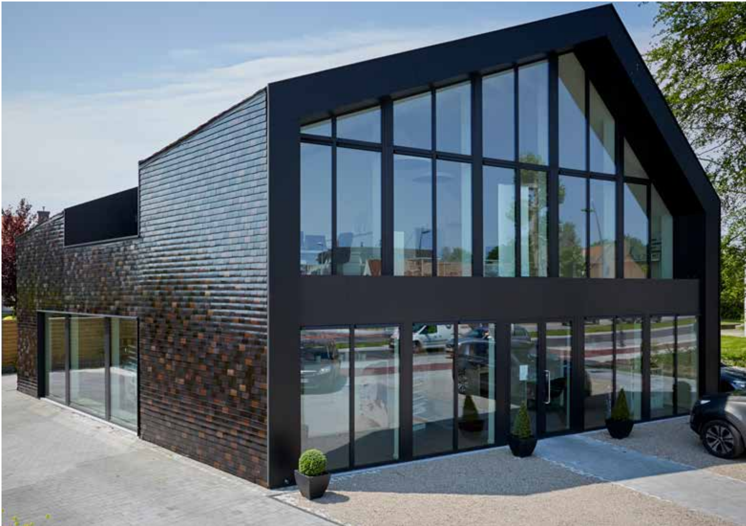
Dak en gevel: Tegelman 301 - Mix van 30% Zwart geglazuurd, 30% Wijnrood geglazuurd, 10% Bruin geglazuurd en 30% Antraciet Architect Koen Deleu, Roeselare
