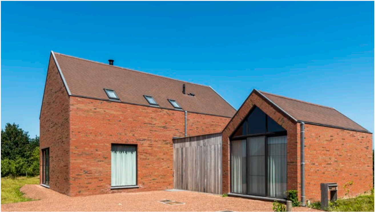
Gevel: Terca Elignia Robinia / Dak: Koramic Tegelpan 301 Rustiek Architectenbureau Dirk Devenyns en Trui Vanden Berghe, Kluisbergen
