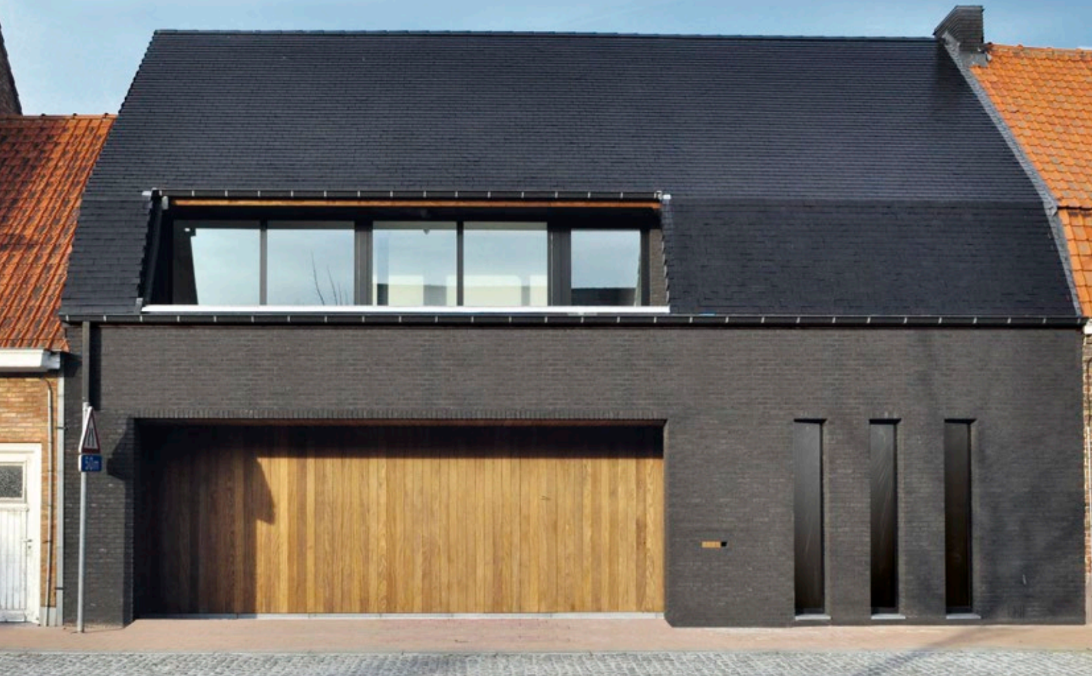
Gevel: Terca Agora Grafietzwart / Dak: Koramic Tegelpan 301 Antraciet Architectenbureau Dries Bonamie, Beernem
