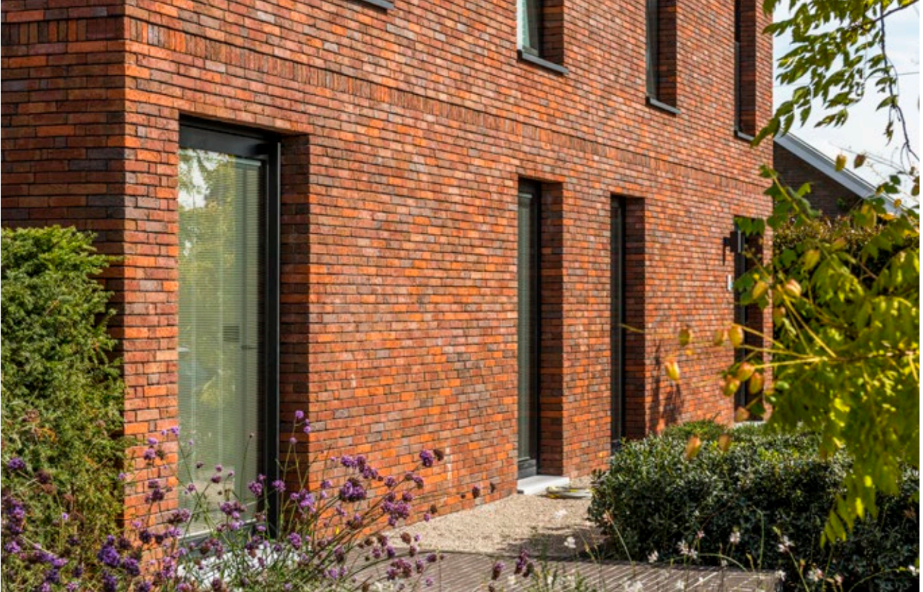
Gevel: Terca Classo Alverna / Dak: Koramic Tegelpan 301 Rustiek Architect Julie D'Aubioul, Waarschoot
