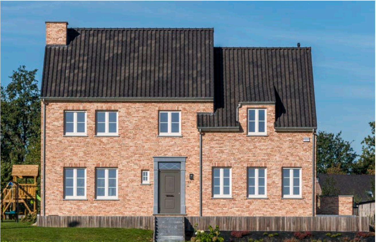
Gevel: Terca Belle Epoque de Mons / Dak: Koramic OVH Klassiek Blauw gesmoord Architect Herman De Becker, Glabbeek
