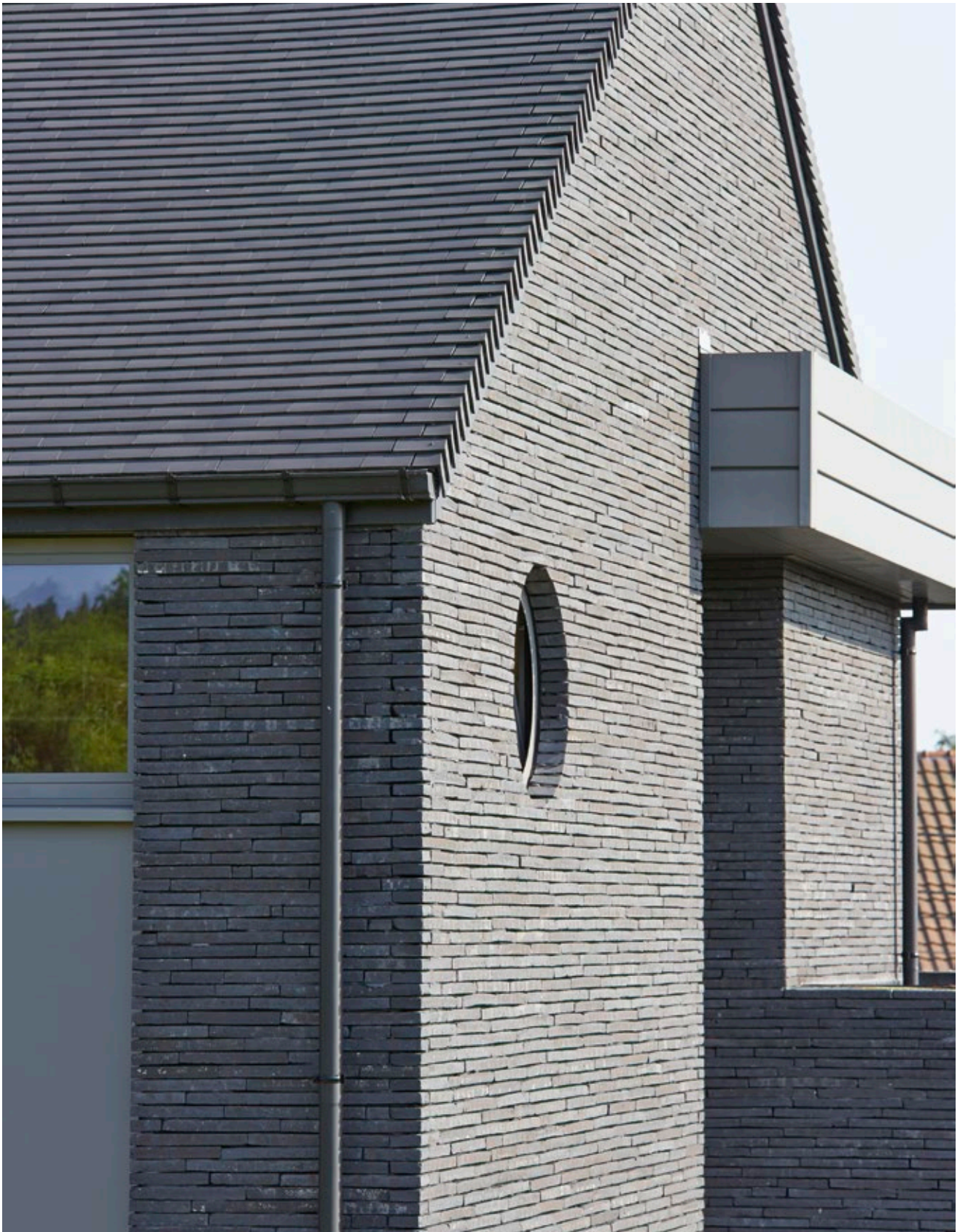
Gevel: Terca Wasserstrich Special Zwart / Dak: Koramic Tegelpan 301 Blauw gesmoord Abepa Architectes, Biesme
