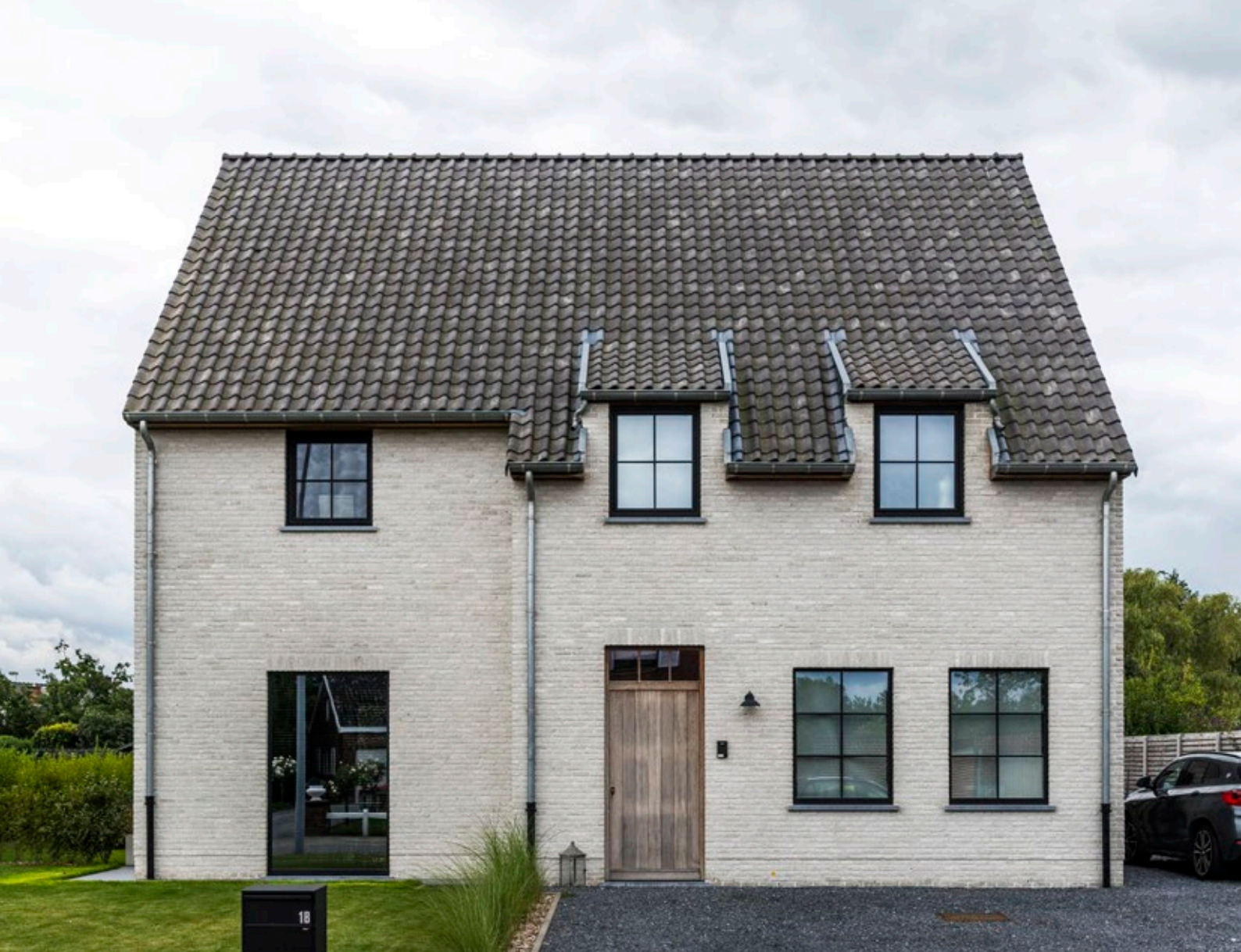
Gevel: Terca Domus Casa Lena / Dak: Koramic Oude Pottelbergse pan 451 Vieilli blauw gesmoord Architect Van Den Abeele Wouter, Kruisem
