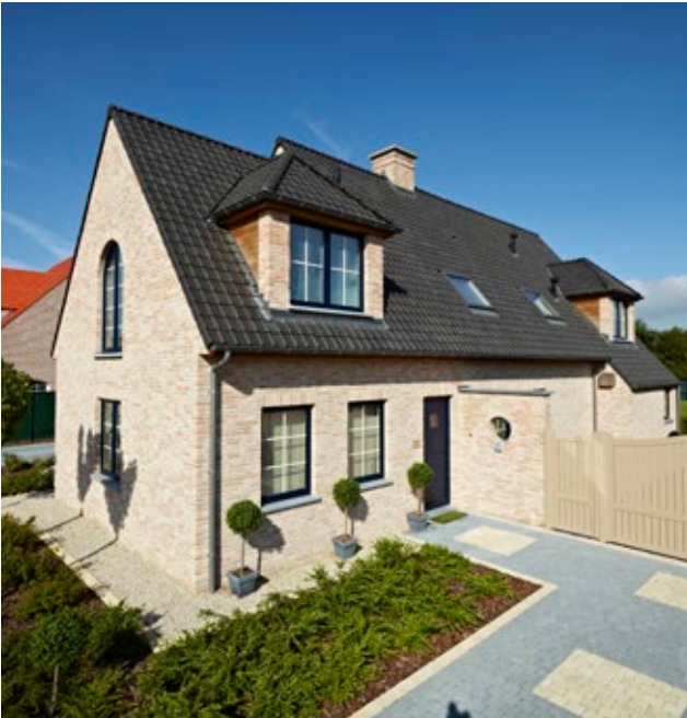
Gevel: Terca Retro Tiffany / Dak: Koramic Stormpan 44 Blauw gesmoord Architectenbureau Nys, Vilvoorde
