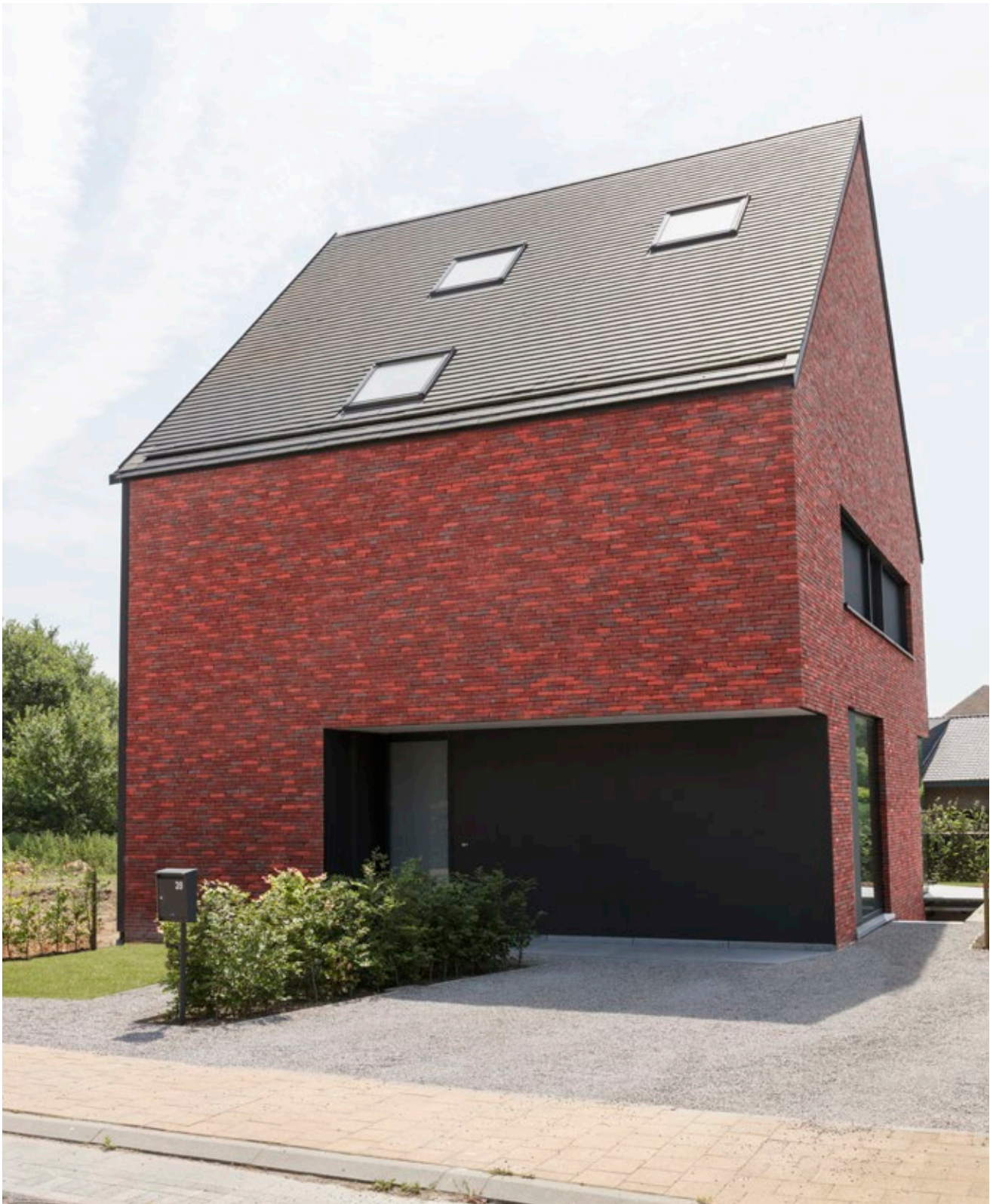
Gevel: Terca Classo Alverna / Dak: Koramic Tegelpan Plato Antraciet mat Geline Thys ir.-architect, Haacht
