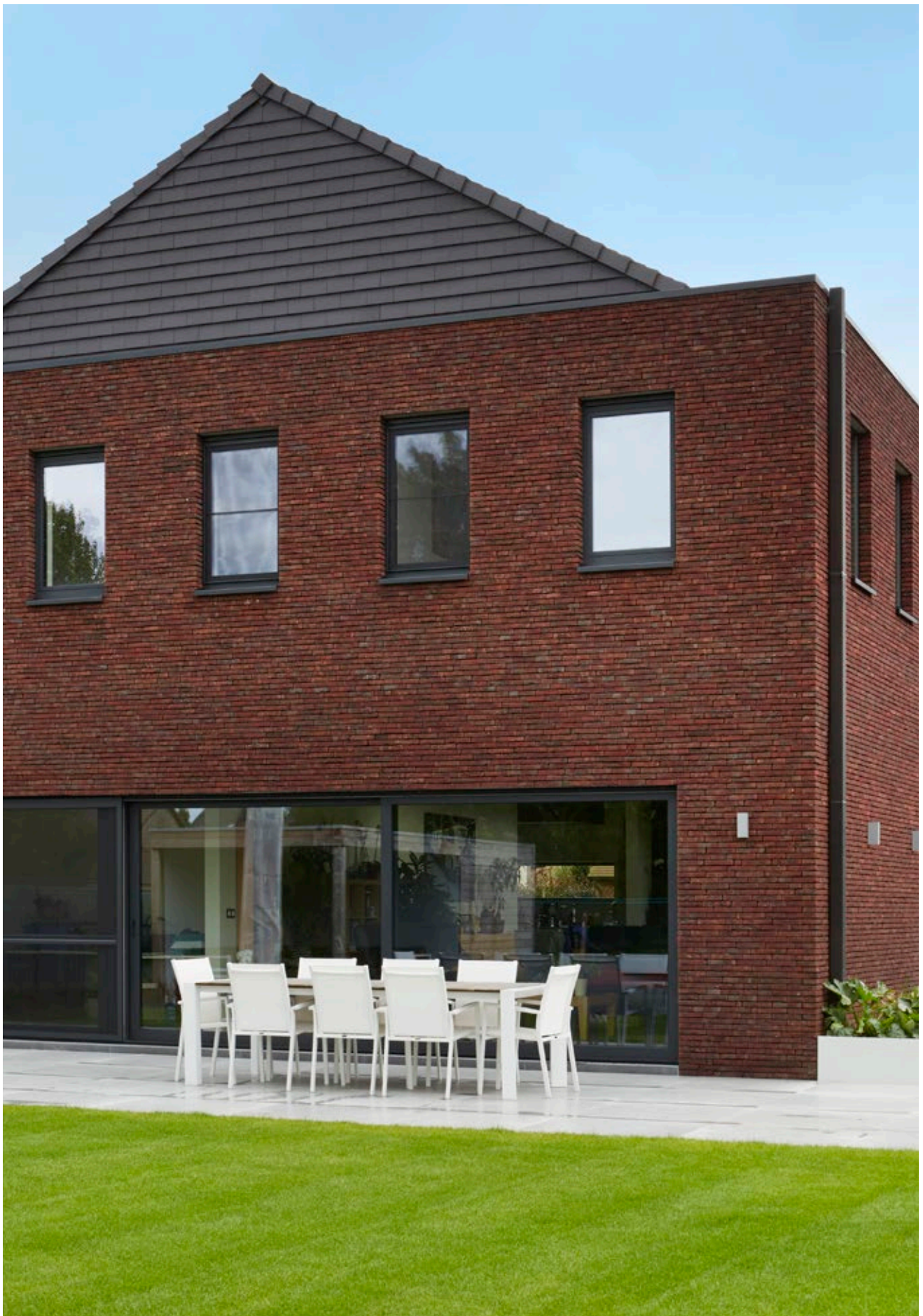
Gevel: Terca Classo Blauw-Rood Genuanceerd Gesinterd / Dak: Koramic Tegelpan Plato Antraciet mat Architectuurbureau Steven Van Hecke, Zele
