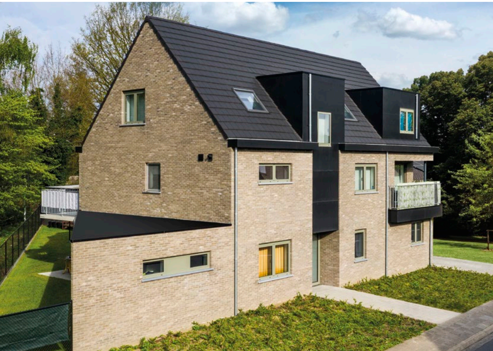
Gevel: Terca Arces Moon Grijs / Dak: Koramic Actua 10 Antraciet mat Architect Augustinus Michiels, Bornem
