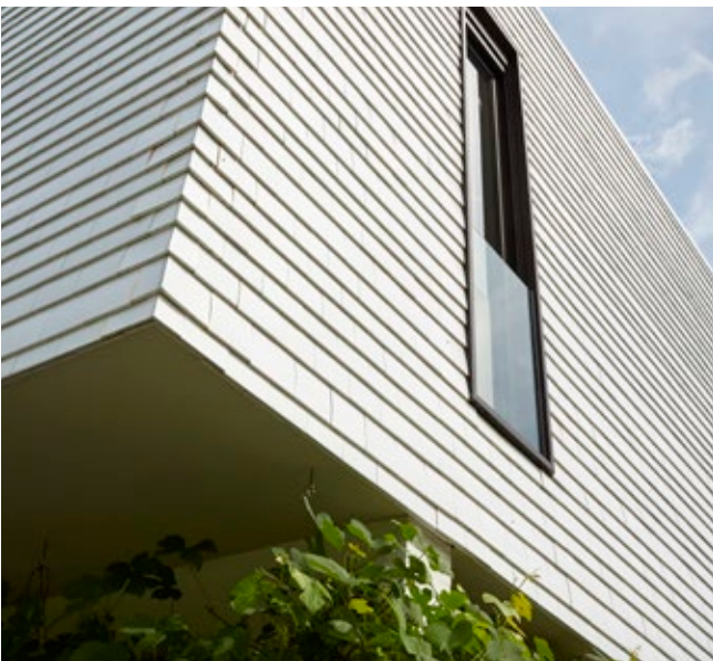
Koramic Tegelpan 301 Wit geglaazuurd ARQ Architecten, Sint-Niklaas
