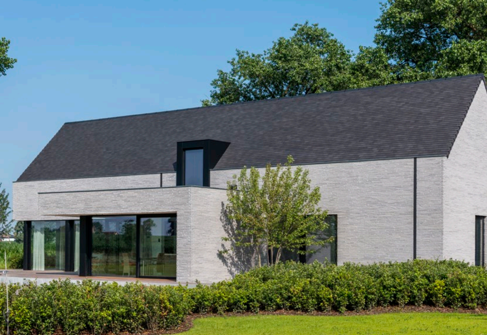
Gevel: Terca Wassertrich Special Grijs / Dak: Koramic Tegelpan 301 blauw gesmoord GC Architecten, Meulebeke
