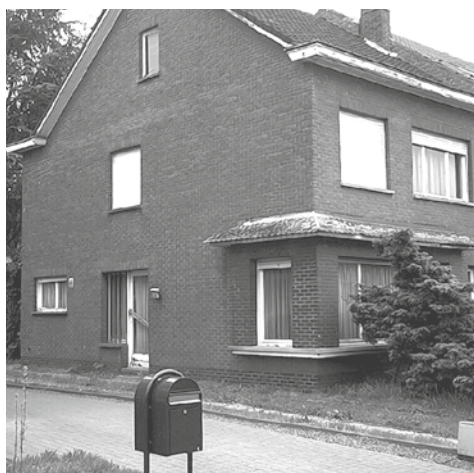
Voor de renovatie
