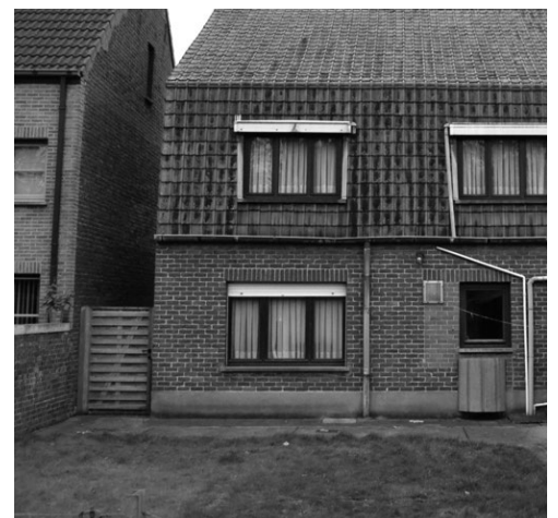
Voor de renovatie
