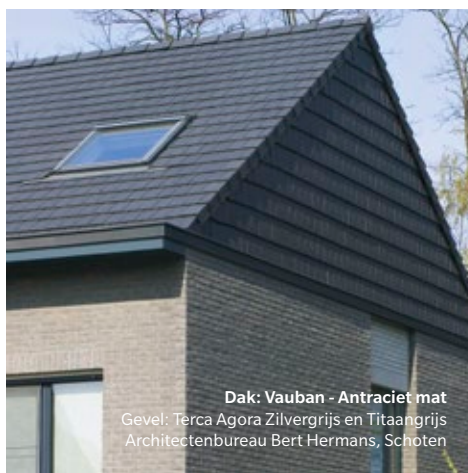
Na de renovatie
